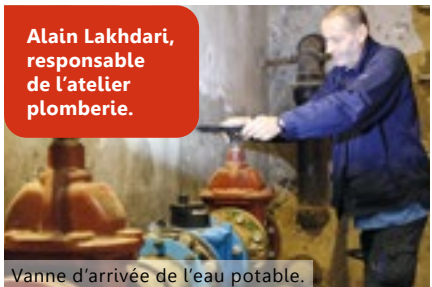
Vanne d'arrivée de l'eau potable.
